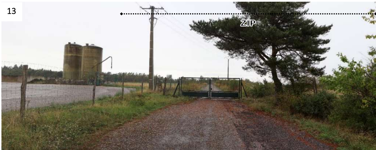
Figure 31 : Vue du portail d'accès à la zone d'implantation potentielle (© ATER Environnement, 2022)
