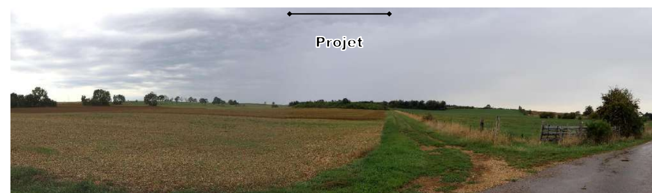
Figure 108 : Vue depuis le sentier de la Haie de Charmois (© ATER Environnement, 2022)
