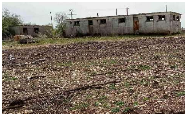
Figure 47 : vieux bâtiments : gîte potentiel pour les chiroptères.
