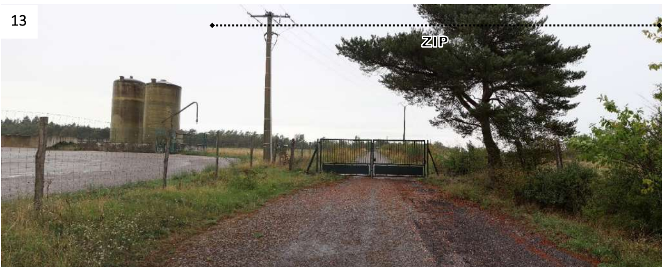
Figure 16 : Vue du portail d'accès à la zone d'implantation potentielle (© ATER Environnement, 2022)
