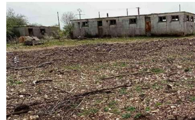
Figure 31 : Vieux bâtiments : nidification des moineaux friquets.
