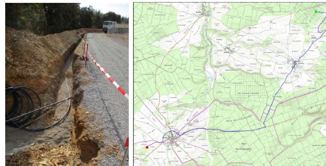
Hypothèse de raccordement entre le projet « Radar » et le poste-source de Muremont
