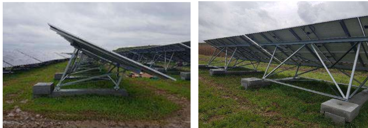
Exemple de fondations béton – Q ENERGY France
