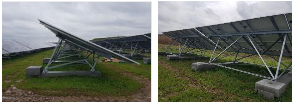
Exemple de fondations béton – Q ENERGY France
