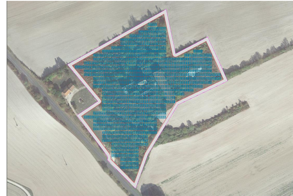
Figure : Variante maximaliste du Parc Photovoltaïque de Noue-le-Loup
