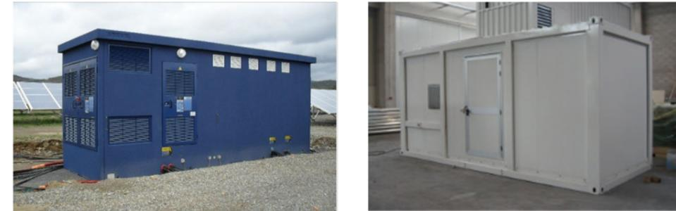
Exemples d'onduleurs et transformateur installés dans postes béton et containers
