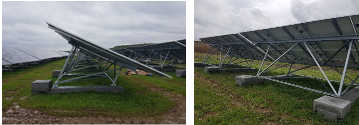
Exemple de fondations béton – Q ENERGY France
