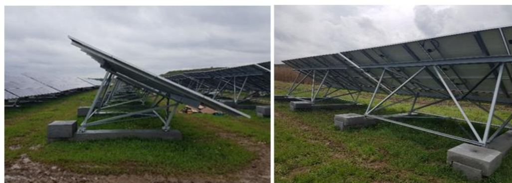
Exemple de fondations béton - Q ENERGY France
