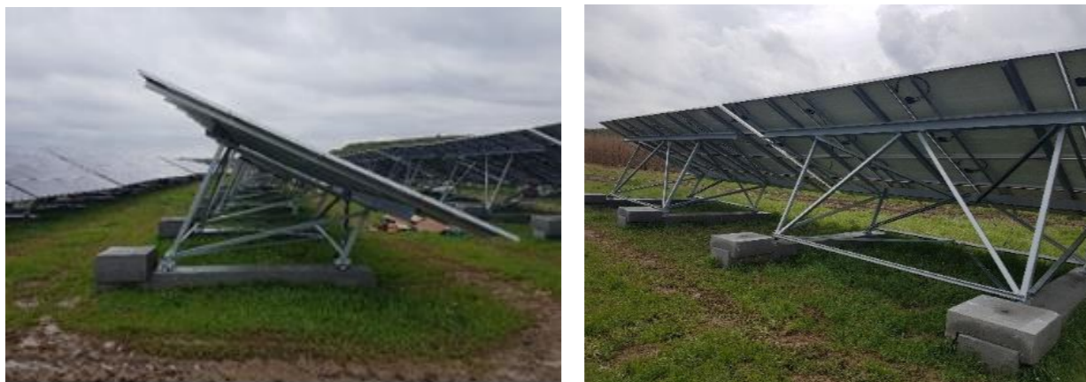
Exemple de fondations béton – Q ENERGY France
