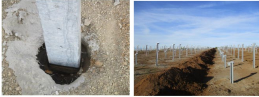
Photographie 3 : Exemple de fondation type pieux - Q ENERGY France
