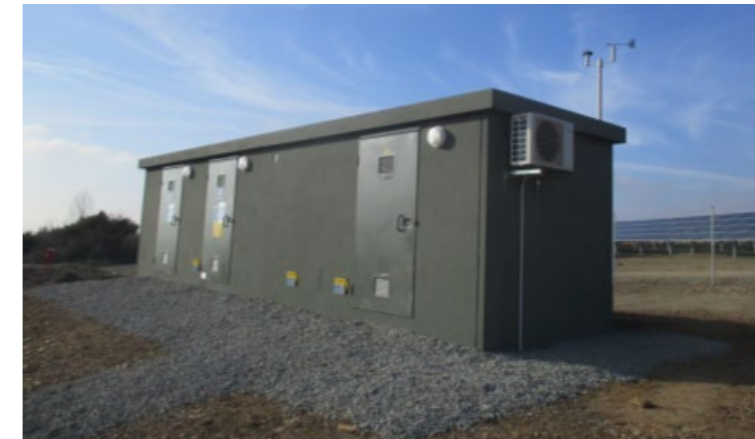
Photographie 6 : Exemple de structure de livraison - Q ENERGY France
