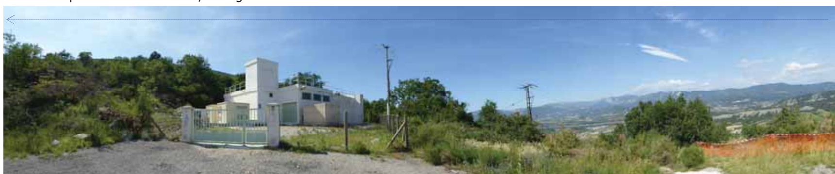
PDV 98- Depuis la station de pompage (limite sud-ouest) le vaste panorama s'ouvre sur le lointain.
