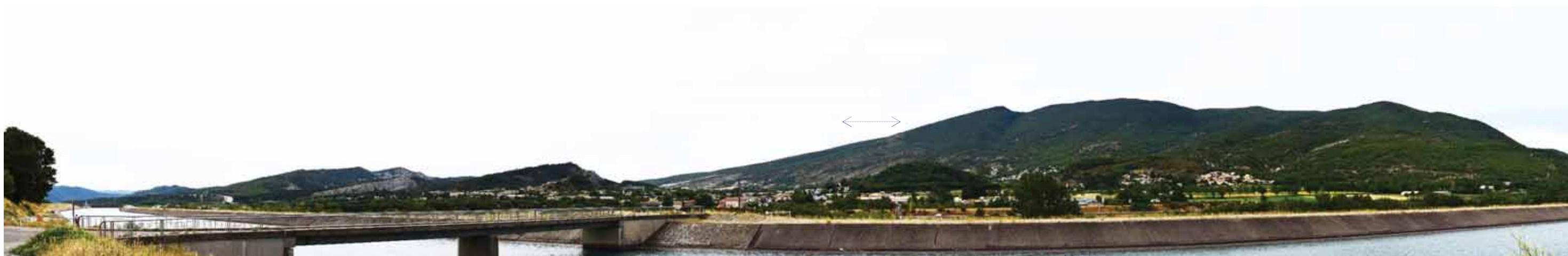
PDV 100 - depuis Salignac à la hauteur du canal, le projet sera perçu au loin épousant le relief. La vue de biais et la végétation présente sur les versants de Lure jouent un rôle important dans la faible perception du site. Sur le premier plan, les composantes humanisées existantes (habitations et construction agricole) offrent des ambiances compatibles avec le projet.
