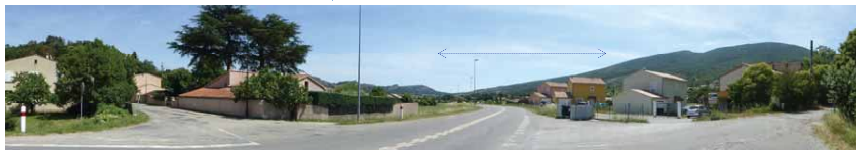
Pdv 80- Le long de la RD 951, des villas récentes marquent le sud de Peipin, le secteur d'étude peut être visible dans le lointain.
