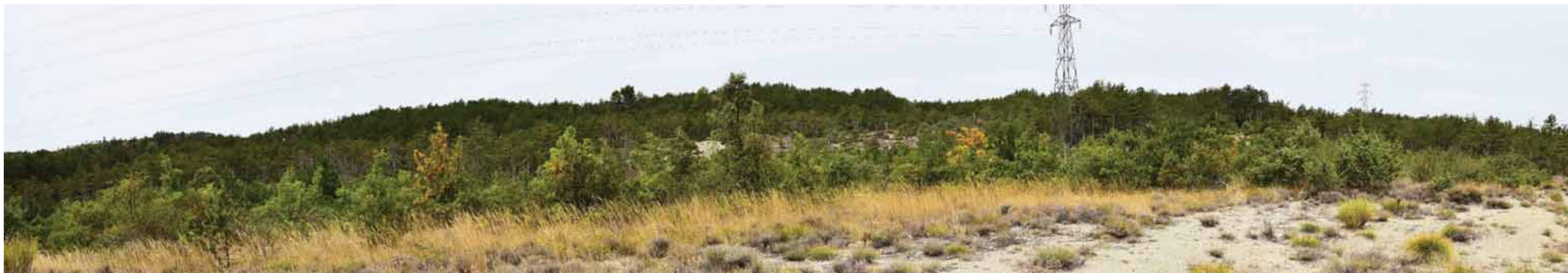
PDV 99 – GR 653D au sud d'Aubignosc et traversant la forêt du prieuré. Le contexte de type naturel est ponctué de pylônes électriques fortement visibles. Les reliefs masquent le site du projet sur l'essentiel du tracé du sentier
