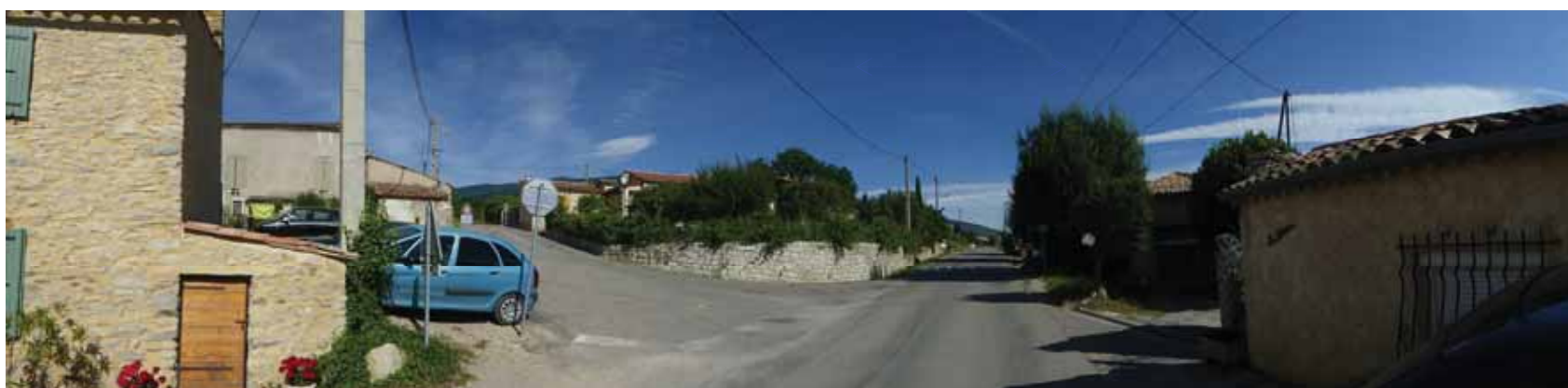
Pdv 34- Lors de la traversée des espaces habités, ici les Chabannes, le paysage environnant ne peut être perçu.
