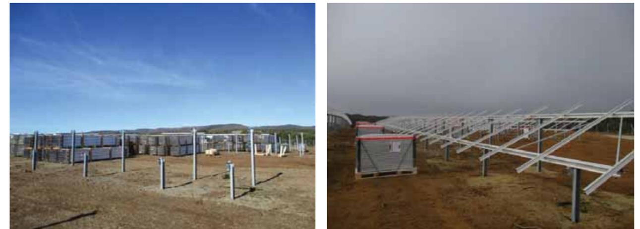
Photographie 11. Assemblage des structures sur site - RES
