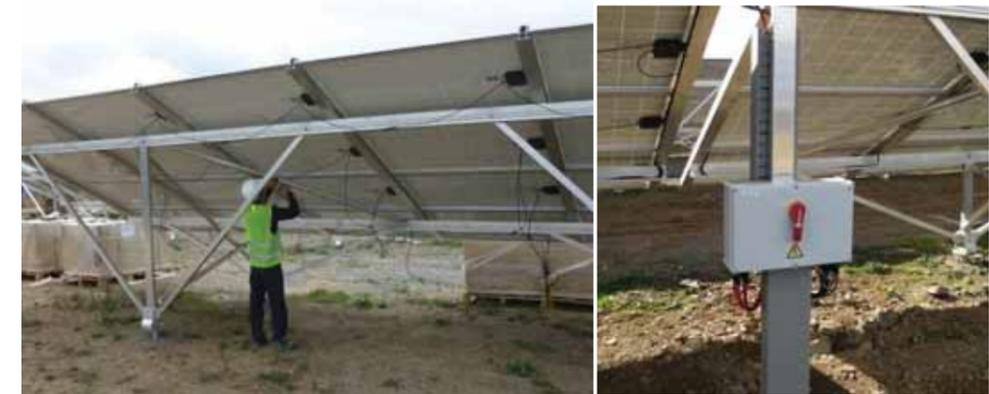
Photographie 15. À gauche : Câblage des panneaux - A droite : Boîtier de raccordement - RES
