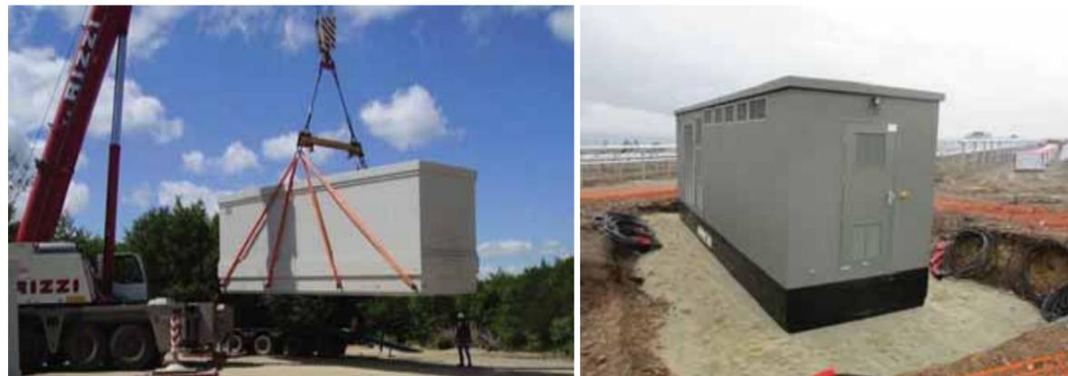
Photographie 14. Installation d'un poste électrique - RES
