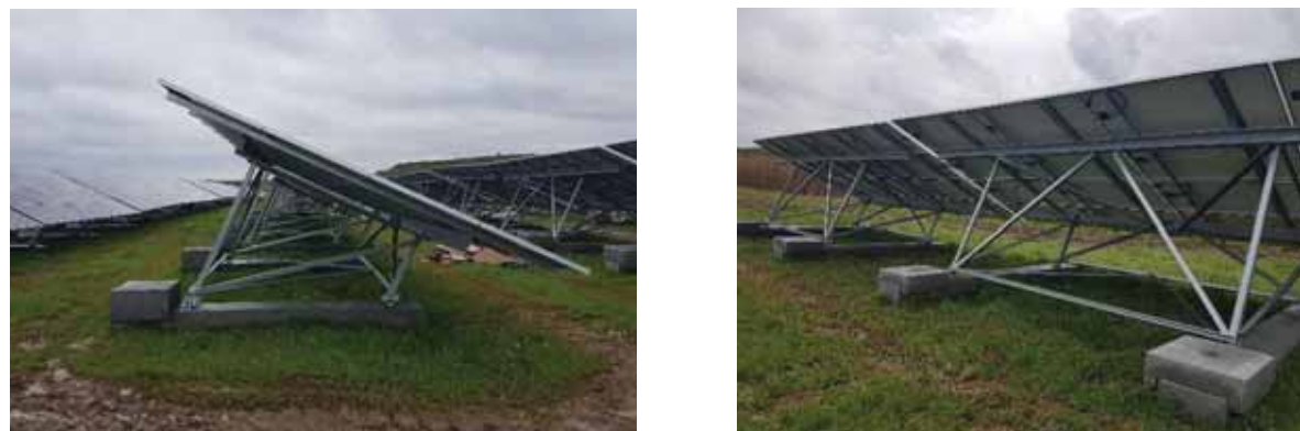
Photographie 76. Exemple de fondations béton - RES
