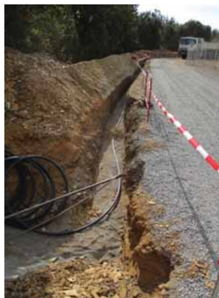
Photographie 86. Exemple de tranchée en bordure de piste - RES
