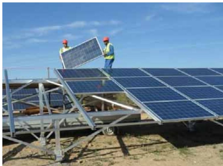
Photographie 85. Exemple de mise en place des panneaux sur les structures - RES
