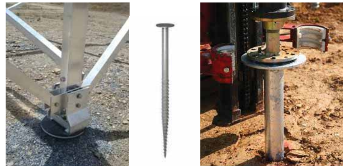
Photographie 75. Fondations à visser- RES
