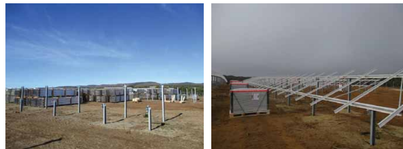
Photographie 84. Assemblage des structures sur site - RES
