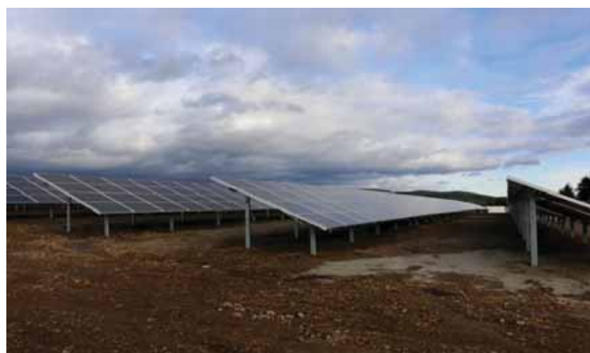
Photographie 83. Exemple d'espace non empierré entre tables - RES
