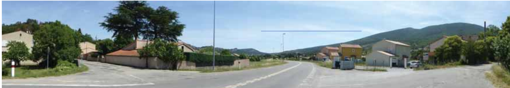
Pdv 80- Le long de la RD 951, des villas récentes marque le sud de Peipin, le secteur d'étude peut être visible dans le lointain.
