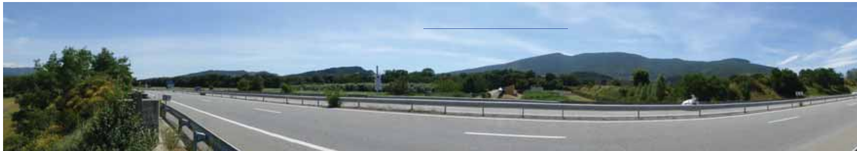
Pdv 73- Depuis l'A75, le paysage de vitesse permet peu ou pas de vue possible sur le secteur d'étude.
