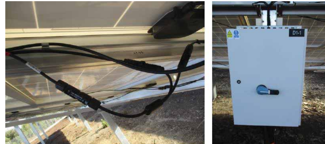
Photographie 81. Exemple de câble électrique et de boîte de raccordement - RES
