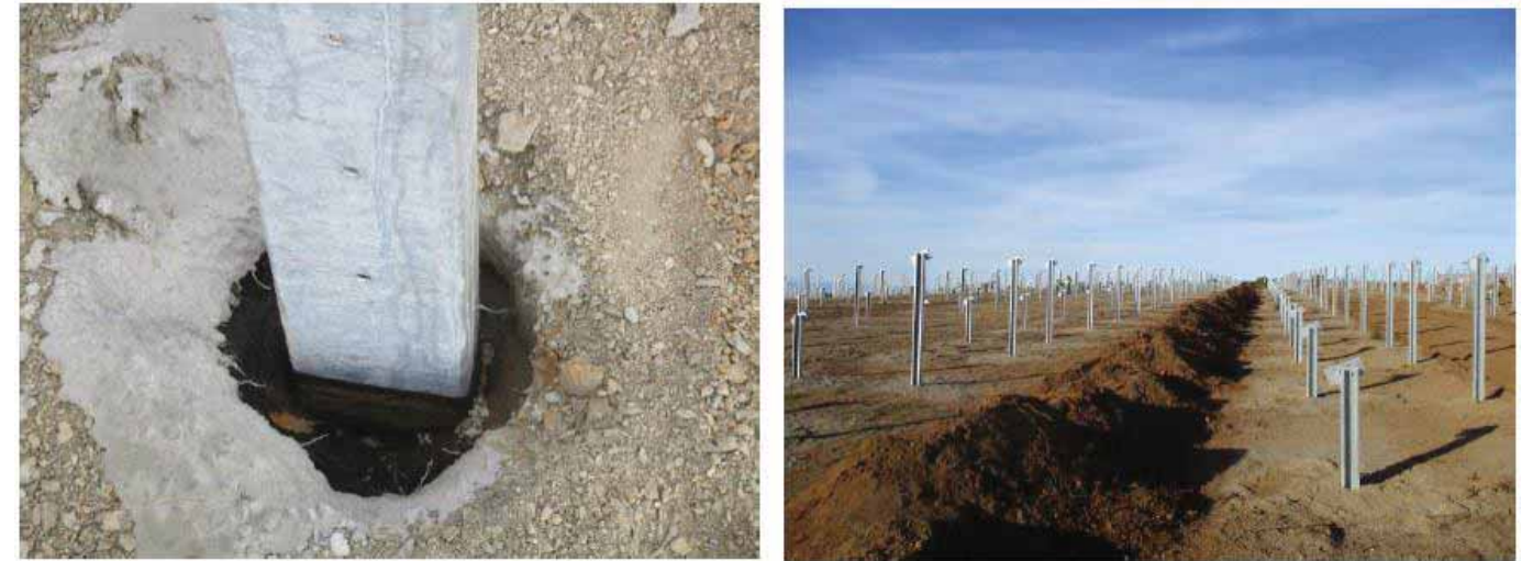
Photographie 74. Exemple de fondation type pieux - RES
