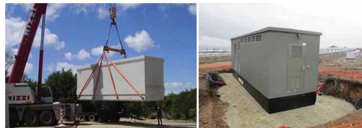
Photographie 87. Installation d'un poste électrique - RES
