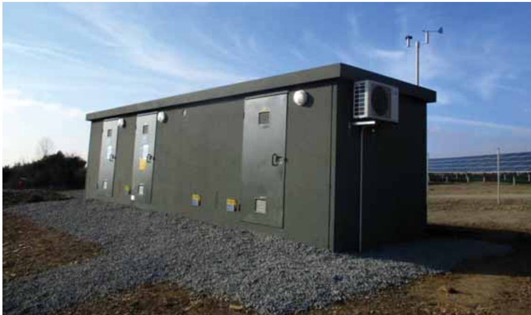
Photographie 80. Exemple de structure de livraison - RES
