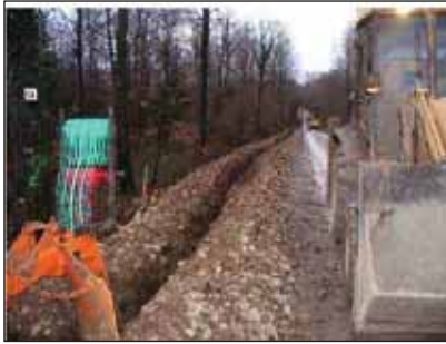
Les câbles électriques de raccordement sont enterrés le long du réseau public existant à l'aide d'une trancheuse.
